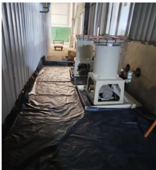
过滤机下方铺设防渗膜
