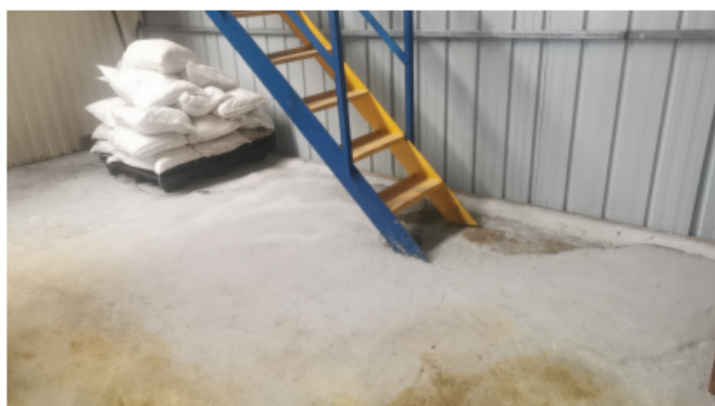
底部地面区域硬化及缝隙用水泥封死
