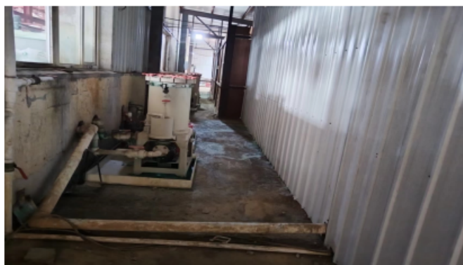
过滤机与污水设备隔离后的照片
